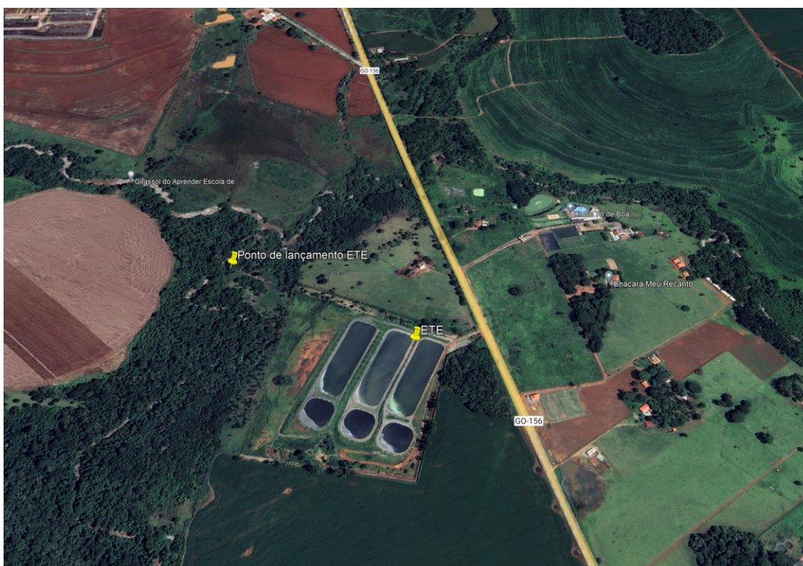
Figura 5.68: Vista aérea da Estação de Tratamento de Esgoto e seu ponto de lançamento do efluente tratado.
