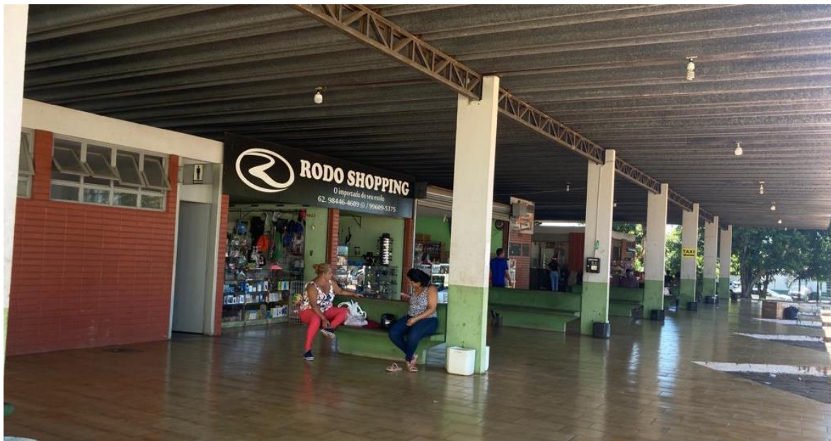
Figura 6.54: Terminal Rodoviário de Itaberaí. Fonte: ITCO (2023).
