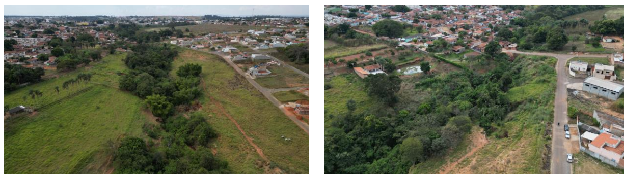
Figura 5.22: Erosões ao longo do Córrego Jambreiro com deposição de lixo doméstico e entulhos de construção civil.
