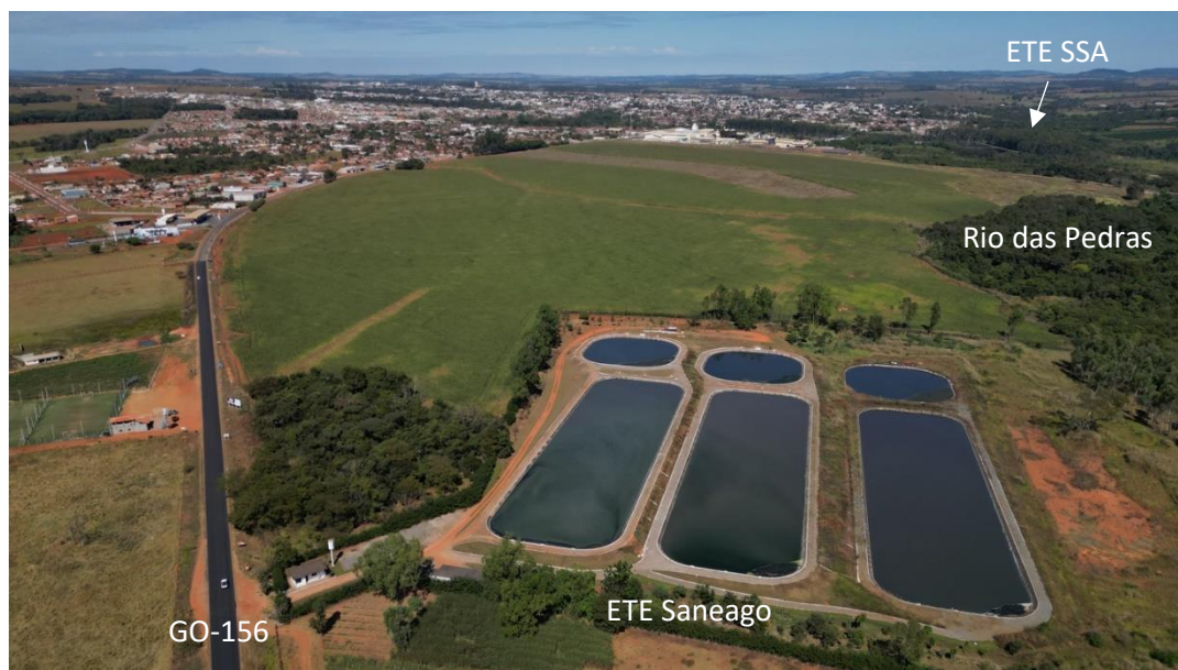
Figura 5.29: Vista da ETE da Saneago entre a GO-156 e o Rio das Pedras com a ETE da SSA ao fundo.
