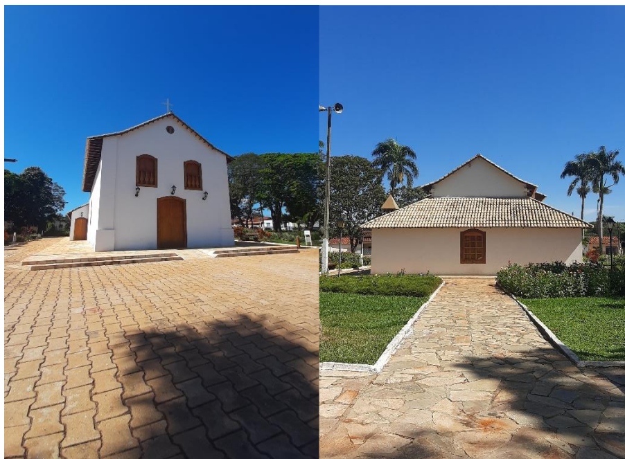
Figura 6.31: Fachadas Frontal e posterior da Igreja Nossa Senhora D'Abadia atualmente. Nota-se que apesar das alvenarias novas, a volumetria tradicional foi mantida. Fonte: ITCO, 2023.
