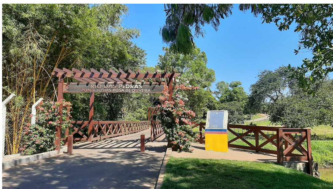
Figura 6.39: Ponte do Rio das Pedras, o potencial da paisagem não foi adequadamente reconhecido.
