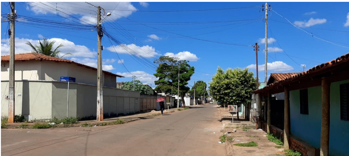
Figura 6.65: Degraus e pavimentação inadequada, posicionamento de lixeiras e arborização em relação à faixa de passagem são situações comuns encontradas nas calçadas de Itaberaí, levam aos transeuntes a utilizar a faixa de rolamento dos veículos.
