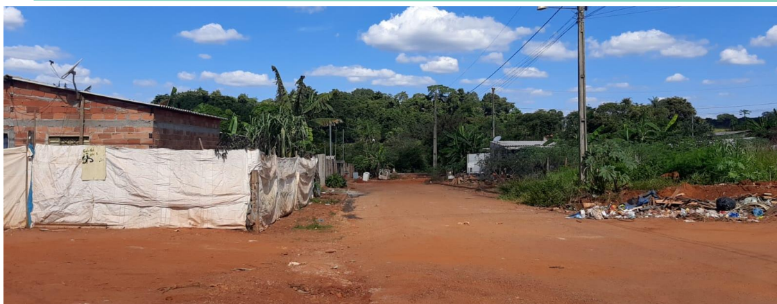
Figura 6.68: Condições degradantes encontradas no Residencial Itavily (Assentamento Bom Jesus).
