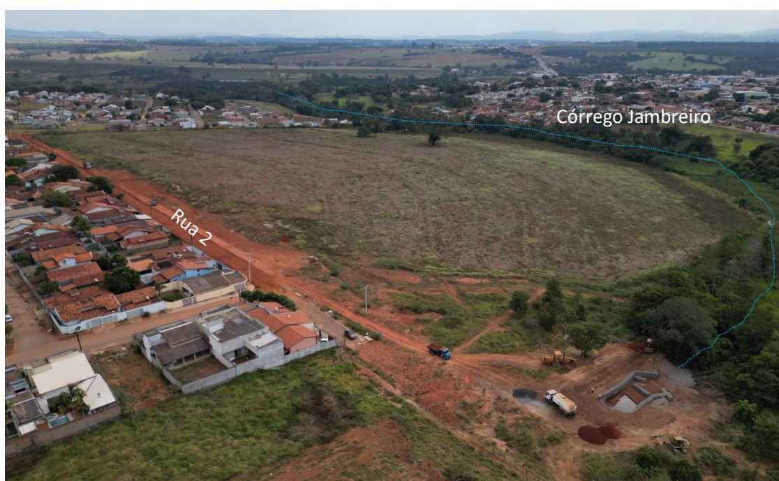
Figura 5.19: Região do Córrego Jambreiro com obra de contenção de lançamento de águas na cabeceira e área destinada a plantação próximo as margens com pouca vegetação nativa.
