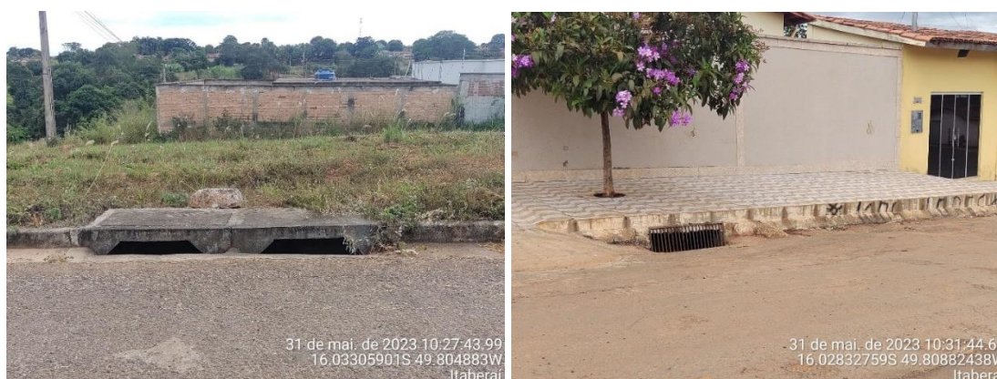
Figura 5.73: Dispositivos de drenagem em Itaberaí.
