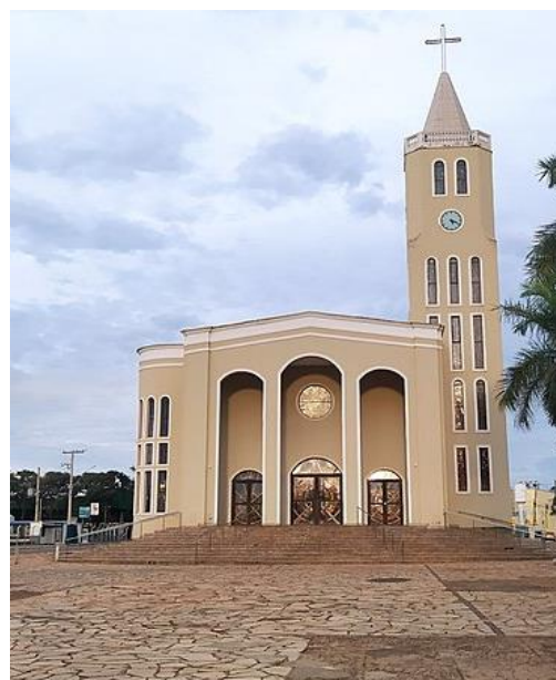
Figura 6.33: Fachada da Igreja de São Sebastião hoje, após a reforma é possível ver que a praça também sofreu alterações em seu desenho. Fonte: ITCO, 2023.
