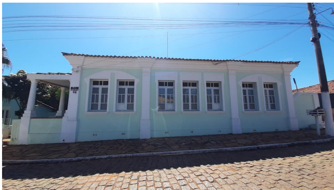
Figura 6.26: Sobrado nas proximidades da Igreja Nossa Senhora D'Abadia. Aqui identificamos uma tipologia típica do século XIX que é o sobrado alinhado à via, com porão elevado e acesso lateral. O padrão decorativo remete ao clássico, já identificamos a presença de esquadrias de madeira com vidro e uma pequena mudança na implantação tradicional, com a incorporação do afastamento em um dos lados do terreno.
