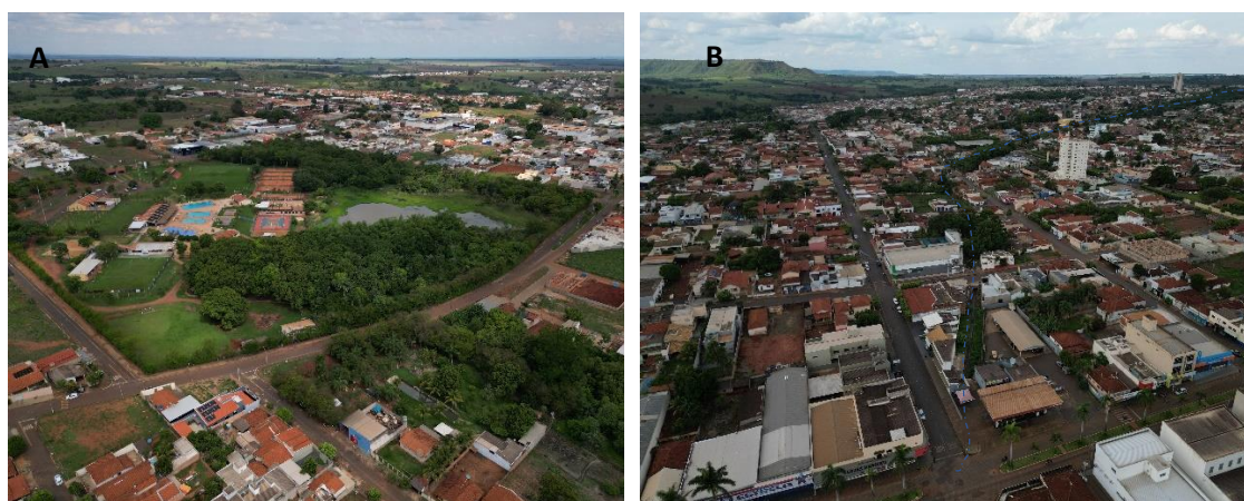
Figura 5.27: A) Região da nascente do Córrego Cruzeiro. B) Córrego Cruzeiro (tracejado azul) e canalização.
