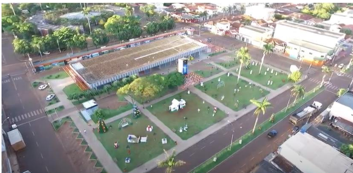
Figura 6.83: Terminal Rodoviário de Quirinópolis. Fonte: Silvio Soares, 2016.
