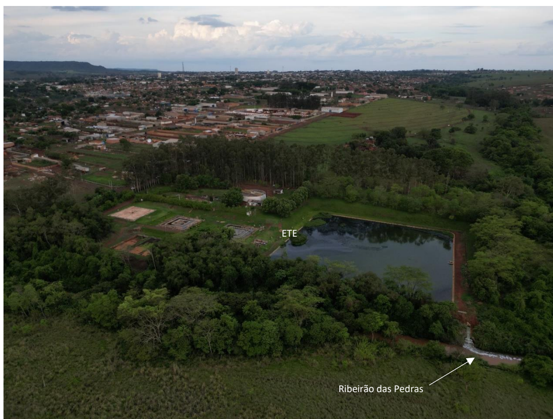
Figura 5.30: Vista geral da ETE.
