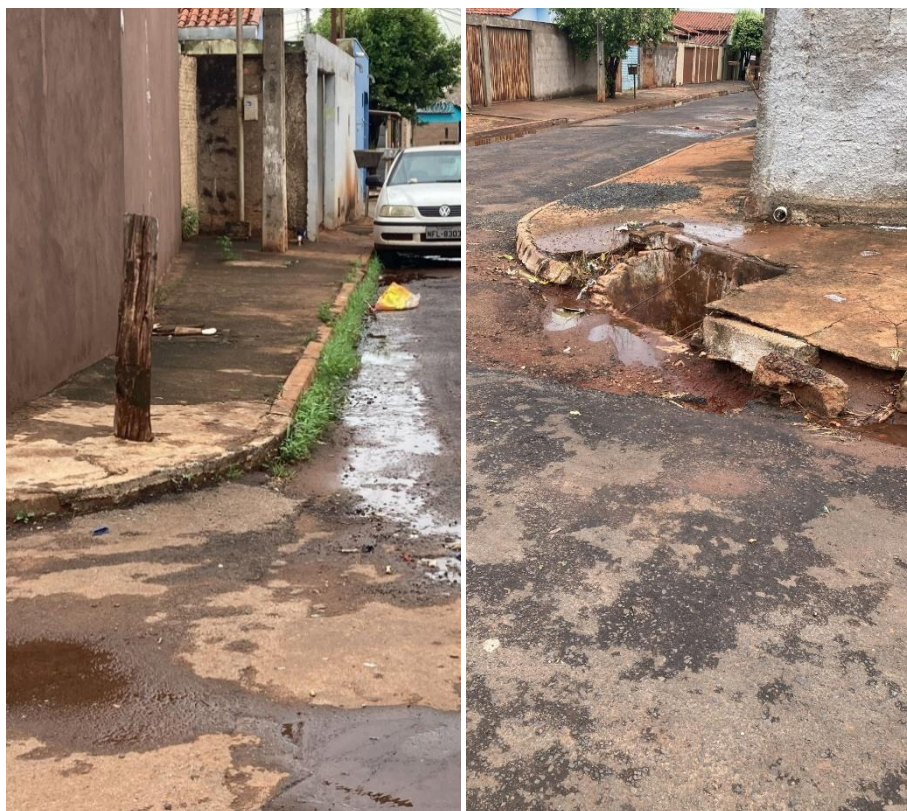
Figura 6.44: Calçadas com dimensões inadequadas.
