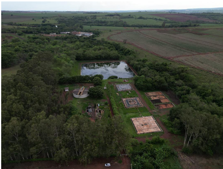
Figura 5.71: Vista aérea da Estação de Tratamento de Esgoto. Fonte: ITCO (2022).
