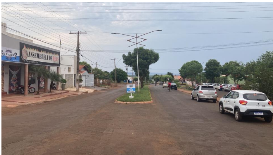
Figura 6.19: Avenida comercial no Bairro Santo Antônio. Fonte: ITCO, 2022.
