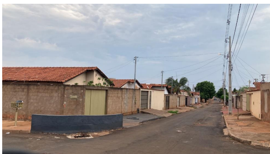
Figura 6.36: Mureta construída na calçada para conter a água da chuva.
