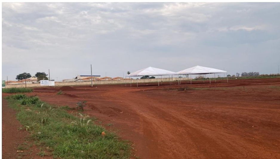
Figura 6.29: Imagem das obras de infraestrutura nos loteamentos Sodino Vieira, Paraíso, Planalto e Progresso.
