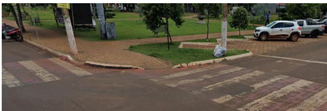
Figura 6.67: Rampa de acesso fora da norma na Av. Brasil. Fonte: Google Earth (2018).
