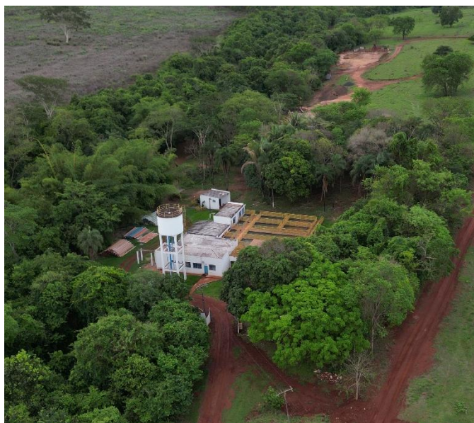
Figura 5.67: Vista aérea da Estação de Tratamento de Água. Fonte: ITCO (2022).
